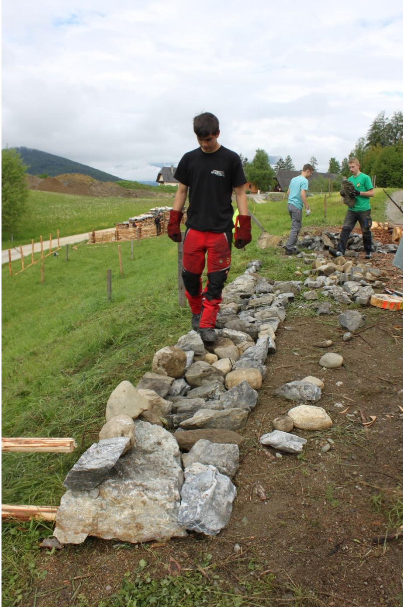
Langsam nimmt die neue Steinmauer nach Vorbild der alten Steinbegrenzung beim Hiasnhof in Göriach Gestalt an. (Foto: Burgi Kaiser)
